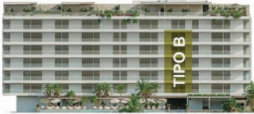
UBICACIÓN EN FACHADA
